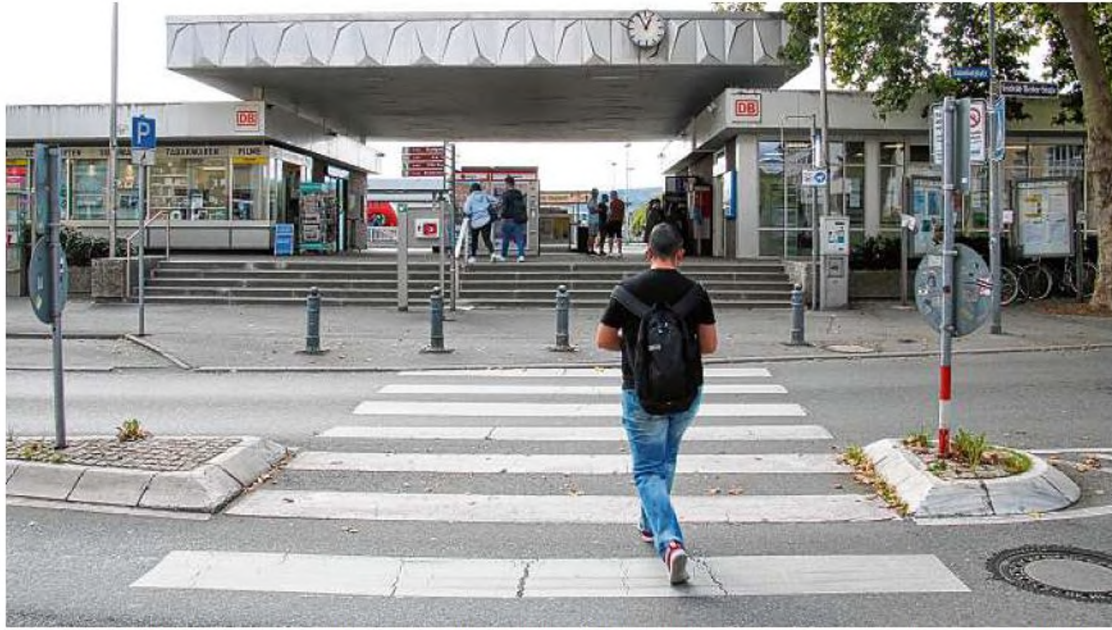
Um auf die Bahnsteige oder an den See zu kommen, heißt es am Bahnhof Radolfzell: Zuerst geht es die Treppen rauf, dann runter. Und biteschön, oben in der Mitte unfallfrei den Fotoautomaten umkurven. BILD: GEORG BECKER
